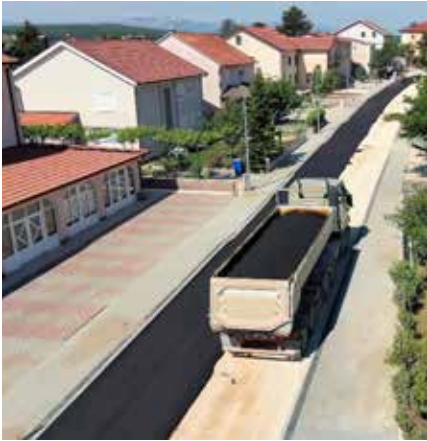
Novi asfalt, nogostup i rasvjeta u Ulici H.S. Kosače
