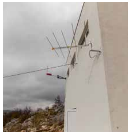
Puštena u rad crpna stanica Zmijjinac (Rakitno)
