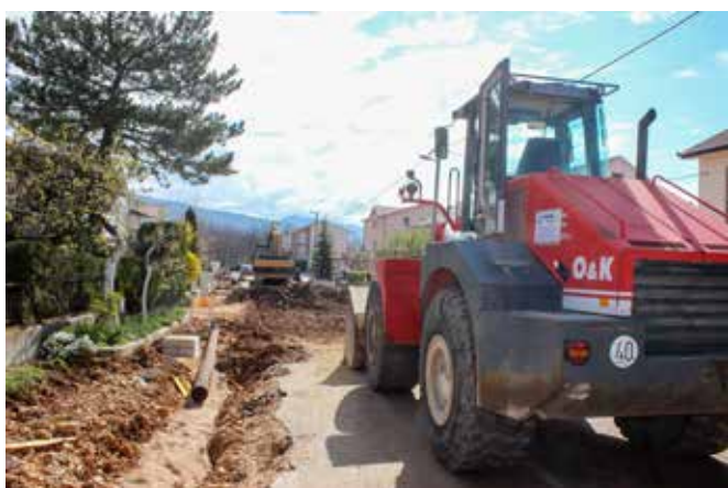
U Ulici H.S. Kosače prvi put ugrađeni digitalni mjerni satovi
