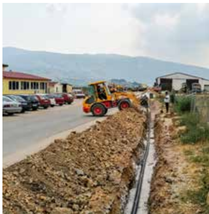
Radovi na vodovonoj mreži Rakitno
