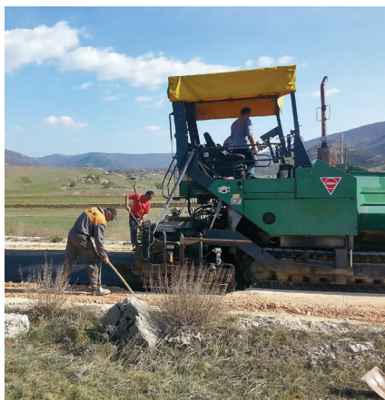
Sanacija ceste Mukinje - Zbornjača, 10.4.2014.
