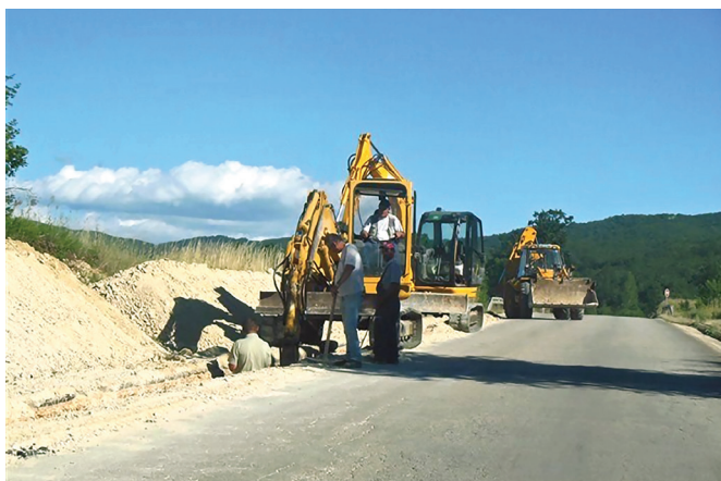
Radovi na proširenju vodovodne mreže
